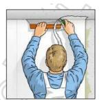
4. Enlever les excédents du plafond, des plinthes, des fenêtres etc. à l'aide d'une spatule en plastique et d'un
